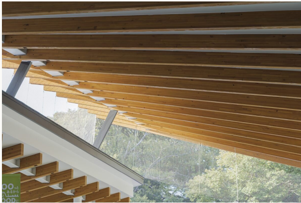
02 SOUS LA TOITURE
